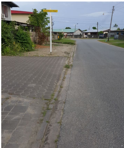
Voorbeeld van een doorlopende, niet verzonken trottoirband
